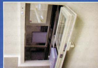
Передаточный материальный шлюз - бокс на три помещения
